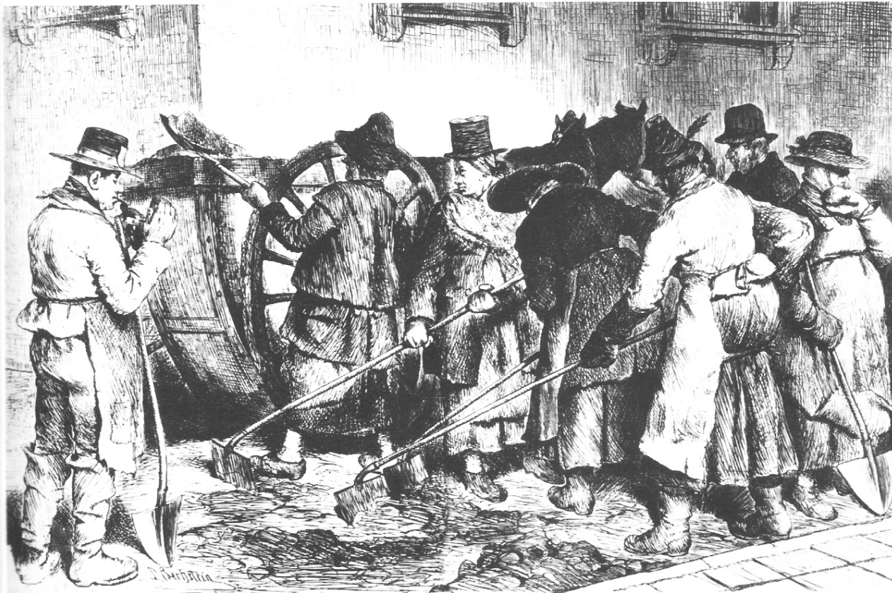
Abb. 58: München 1872: Weibliche Arbeitskräfte bei der Straßenreinigung.
