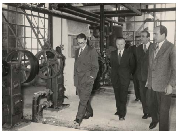
Φ3- Οι δοσομετρικές αντλίες με μαντοκίνηση. Από επίσκεψη του Σοφ. Βενιζέλου. Δεξιά ο Γ. Συρεγγέλας
