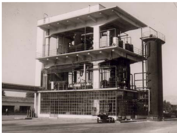
Φ6-Το κτίριο της φουρφουράλης
