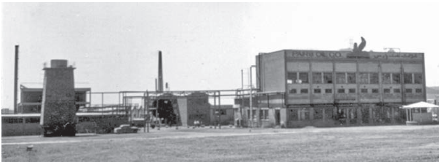
13. Η εγκατάσταση της PARS OIL στο Ιράν, γενική άποψη.
