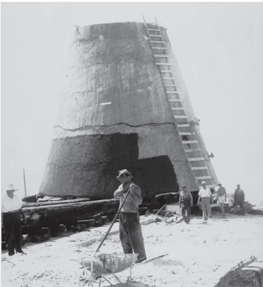
10. Η νησίδα πρόσδεσης δεξαμενοπλοίων του Περάματος, έτοιμη για καθέλκυση.
