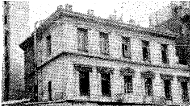
Τὸ κτίριο, στὸ ὁποῖο ἐστεγαζόντο οἱ Σχολῆς Ρουσοπούλου καὶ καὶ τὸ περιοδικό τους, στὴν Πλατεῖα Κάνιγγος (1896-1922). Τελευταία φωτογραφία λίγο πρὶν ἀπὸ τὴν κατεδάφισι του (1975).
