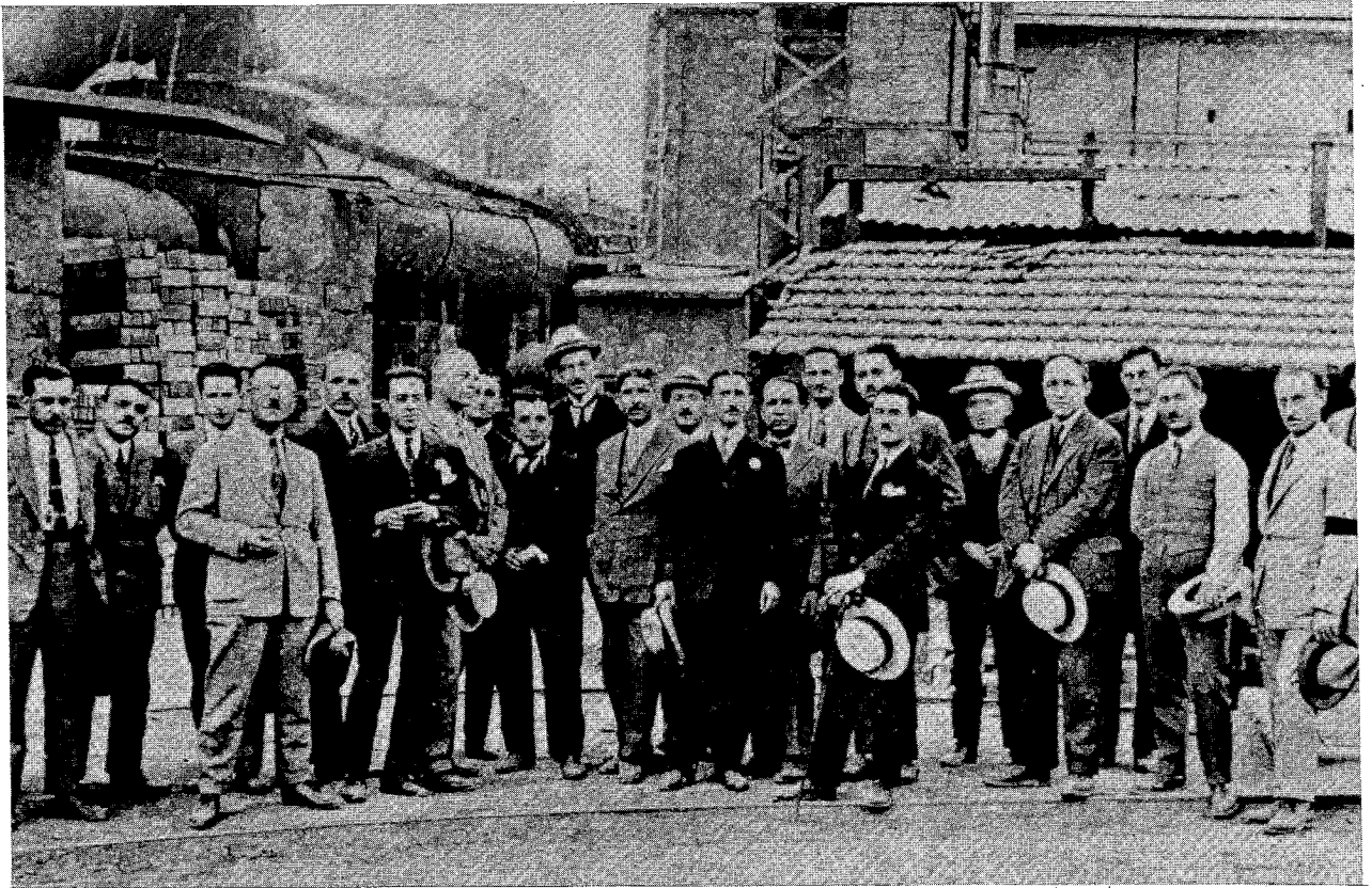
Ἀναμνηστική φωτογραφία (1925) ἀπὸ ἐπίσκεψι μηχανικῶν καὶ χημικῶν στὸ ἐργοστάσιο τῆς Ἑταιρίας Λιπασμάτων. (Πρόκειται γιὰ τὴν πρώτη ἀπὸ τὴς δώδεκα τέτοιες ἐπισκέψεις-ἐκδρομὲς ποὺ ὀργανώθηκαν μετὰ πρωτοβουλία τῶν «Ἔργων»). Στὴν πρώτη σειρὰ διακρίνονται (μετὰ τὸ ἄνθος στὸ πέτο) ὁ Κλεισθένης Φιλάρετος καὶ ὁ γραμματεὺς τοῦ Διούσιος Καραθανάσης.
