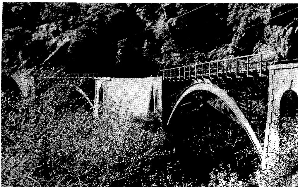
78. Συνέχεια τὰ τεχνικά ἔργα τοῦ ὁδοντωτοῦ. Σήραγες, γαλαρίες, γεφύρια πέτρινα, γεφύρια σιδηρά.
