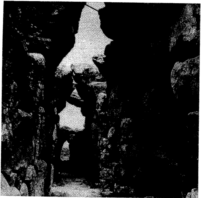
49. Οἱ ὑπόγειοι διάδρομοι τῆς Τίρυνθος πού εἶναι κατασκευασμένοι ἀπό ἀψιδωτά ἀλληλοστηριζόμενους τεράστιους ὀγκολίθους.
