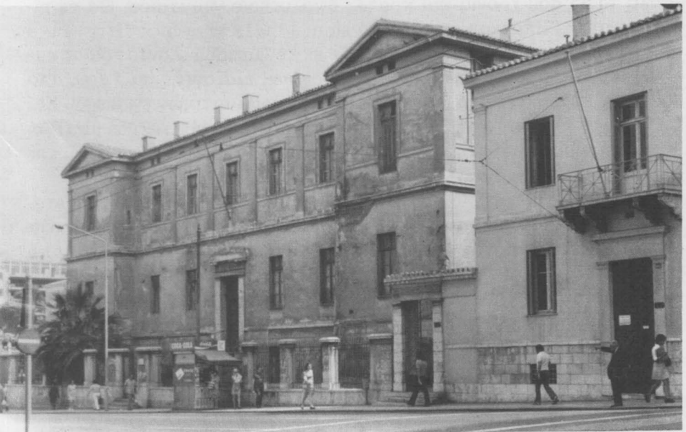
68. Τό μέγαρο Γρηγ. Παπαδοπούλου, πανεπιστημιακό κτῆμα ἀπό τό 1870, πού στέγαζε πολλά ἐργαστήριά του ἐπί μία 100ετία (Φωτ. Ι.Κ. τοῦ 1970).
