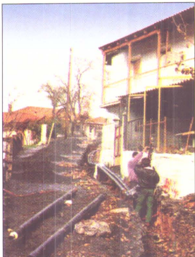
Εγκατάσταση Τηλεθέρμανσης, Νυμφασίας
