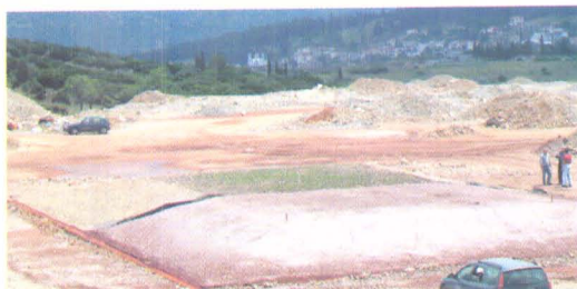
Στεγάνωση επιφάνειας ΧΥΤΑ ή ΧΑΔΑ (Χώροι Ανεξέλεγκτης Διάθεσης Αστικών Απορριμμάτων)
