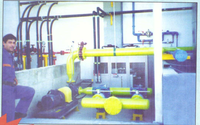
ΕΓΚΑΤΑΣΤΑΣΗ ΚΥΚΛΟΠΕΝΤΑΝΙΟΥ ΣΤΗΝ ΒΙΟΜΗΧ. FRIGOGLOSS
