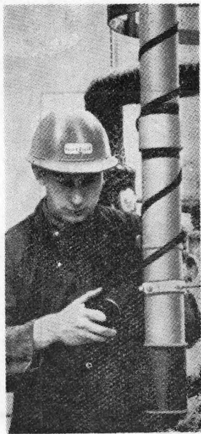
Ἡλεκτρικαὶ θερμαντικαὶ ταινίαι διὰ θέρμανσιν δικτύων εἰς τὴν βιομηχανίαν
