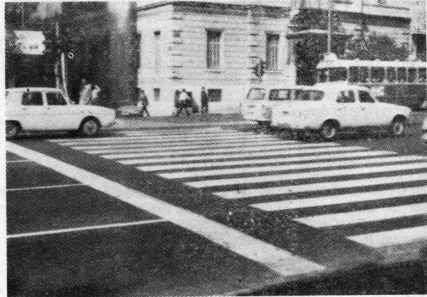
Εἰκ. 2. Λεωφόρος Ἀμαλίας: Διάβασις πεζῶν «Τύπου Ζέμπρας» καὶ STOP διὰ μονίμου θερμοπλαστικοῦ ὑλικοῦ, τοῦ ἰταλικοῦ Ὁργανισμοῦ Σημάνσεως Ὀδῶν «S S S A.C.I.», κατὰ Φεβρουάριον 1968.
