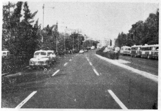
Εικ. 4. Λεωφόρος Βασ. 'Ολγας: Κατά μήκος διαγράμμισις δι' ήμιμονιμου θερμοπλαστικού υλικου, του Ιταλικου 'Οργανισμου Σημάνσεως 'Οδών «S S S A.C.I.», κατά Φεβρουάριον 1968.
