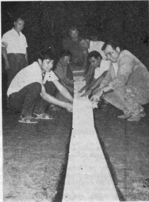
Εἰκ. 5. Λεωφόρος Πανεπιστημίου: Κατὰ μήκος δοκιμαστικὴ διαγράμμιση διὰ πλαστικῶν ταινιῶν «Robbins» Η. Π. Α. Φωτογραφία ληφθεῖσα κατὰ τὸν χρόνον τῆς ἐφαρμογῆς τῶν κατ' Αὐγούστου 1967.
