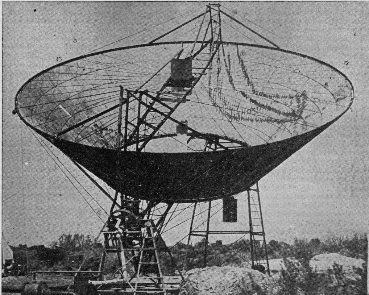
Σχ. 2. Ἡλιακὴ μηχανὴ ἐγερθεῖσα ὑπὸ Ε. Α. Εneas εἰς Arizona τὸ 1903.
