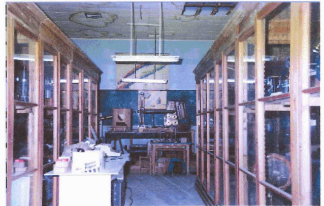
Actual Situation Fig 06: Room 117 ↑N
