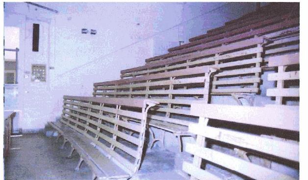
Actual Situation Fig 12: Room 215 ←N
