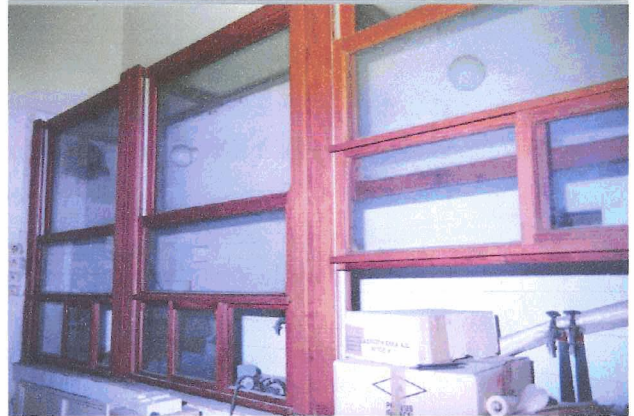
Actual Situation Fig 18: Room 320 ←N
