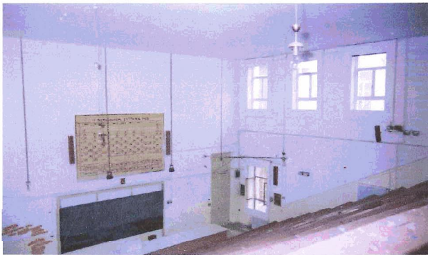
Actual Situation Fig 11: Room 215 ←N
