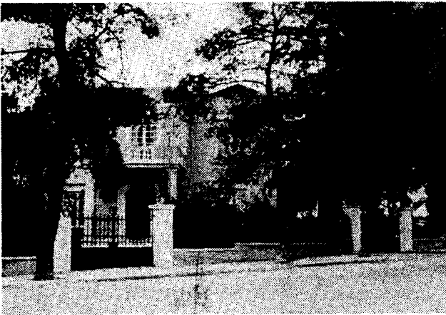
Εικ. 12. Το σπίτι του Χόνδρου στην οδό Μιλτ. Μαλακάση και Στρατηγού Καλλάρη, στο Παλαιό Ψυχικό. Ή εσοδος από την οδό Καλλάρη. (Φωτογραφία Ι.Κανδήλη, σύγχρονη).
